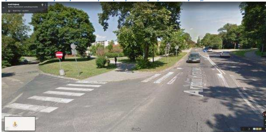
Rysunek 18 Lokalizacja stacji nr 7 w Gryfinie (Przejazd kolejowy z Armii Krajowej)
